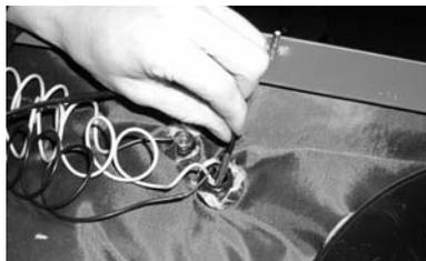
4. Fühlerkabel entsprechend verlegen und durch das Leerrohr führen.
