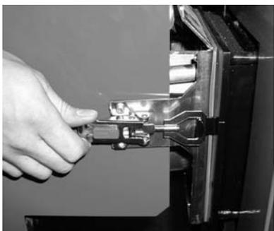
3.6.10 Anbringen des Kesselfühlers und sonstige Leitungen. Dazu befindet sich im Kessel vorne rechts ein Leerrohr welches die Kabel und Fühler von der Oberseite des Kessels nach unten führt.
