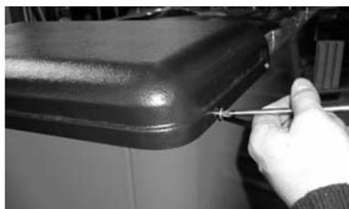
3. Mit gelieferter Kesselfühler der TM 3006 in die Tauchhülse
