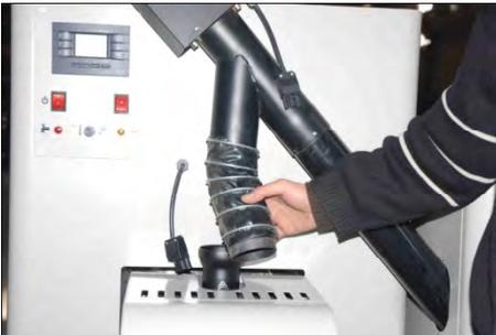
Stellen Sie einen Behälter unter und verbinden Sie die Pelletschnecke erneut mit der permanenten Stromverbindung (Pos. Nr. 6) **ACHTUNG:** Lassen Sie nun die Pelletschnecke exakt **15 Minuten** laufen und messen Sie anschließend das Gewicht der geförderten Pellets, Gewicht ohne Behältergewicht.
